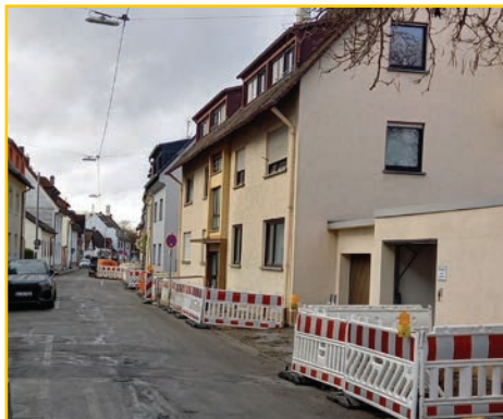
Baumaßnahme in der Rintheimer Hauptstraße, Quelle: Bürgerverein
