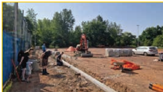
„Engagierte Helfer beim Bau des neuen Kunstrasenplatzes“
