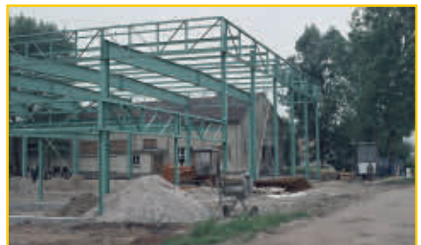
1975: Stahlskelett mit alter Turnhalle im Hintergrund Foto: Bernd G. Weber
